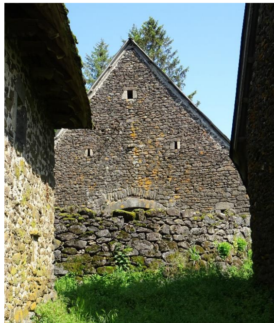
Pignon quasi en pierre sèche de basalte, arc de décharge, aspect-type des granges de la région.
