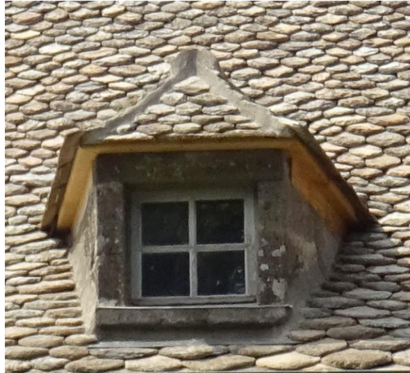
Lucarne typique de la région : plan trapèze, joues en basalte (maison de maître du Puy Soutro, cette toiture vient d'être refaite).
