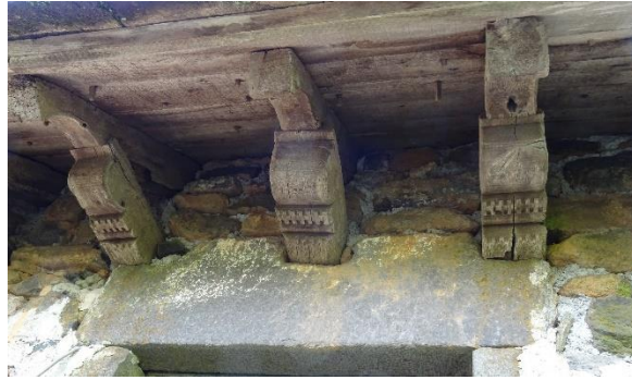
Corbeaux de la maison Filiol.
