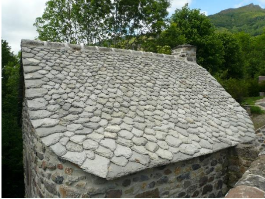
Couverture récente en phonolite (moulin du Falgoux)
