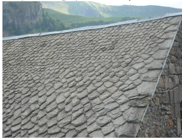
Couverture récente en phonolite (moulin du Falgoux)
