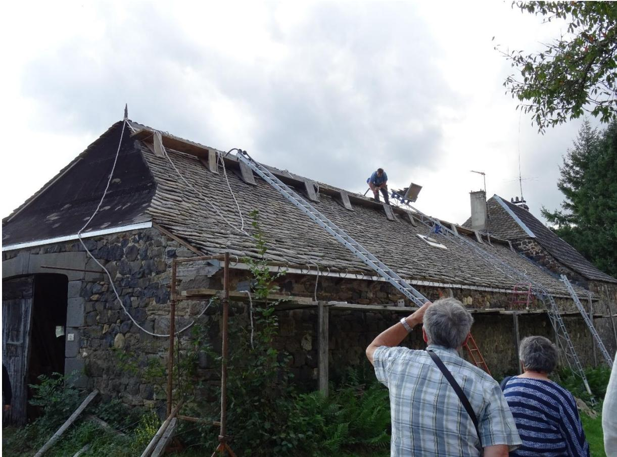
Polignac, réfection d'une toiture (lauzes de gneiss).
