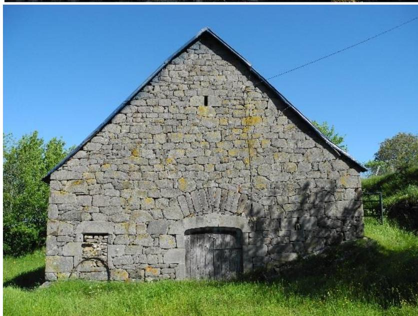
Les pierres taillées des arêtes et des encadrements d'ouvertures sont parfois en basalte, mais plus souvent en laves diverses provenant de la formation des brèches ; on note aussi l'emploi (apparemment assez récent) du trachyte clair de Menet et celui du tuf jaunâtre de Broc.
