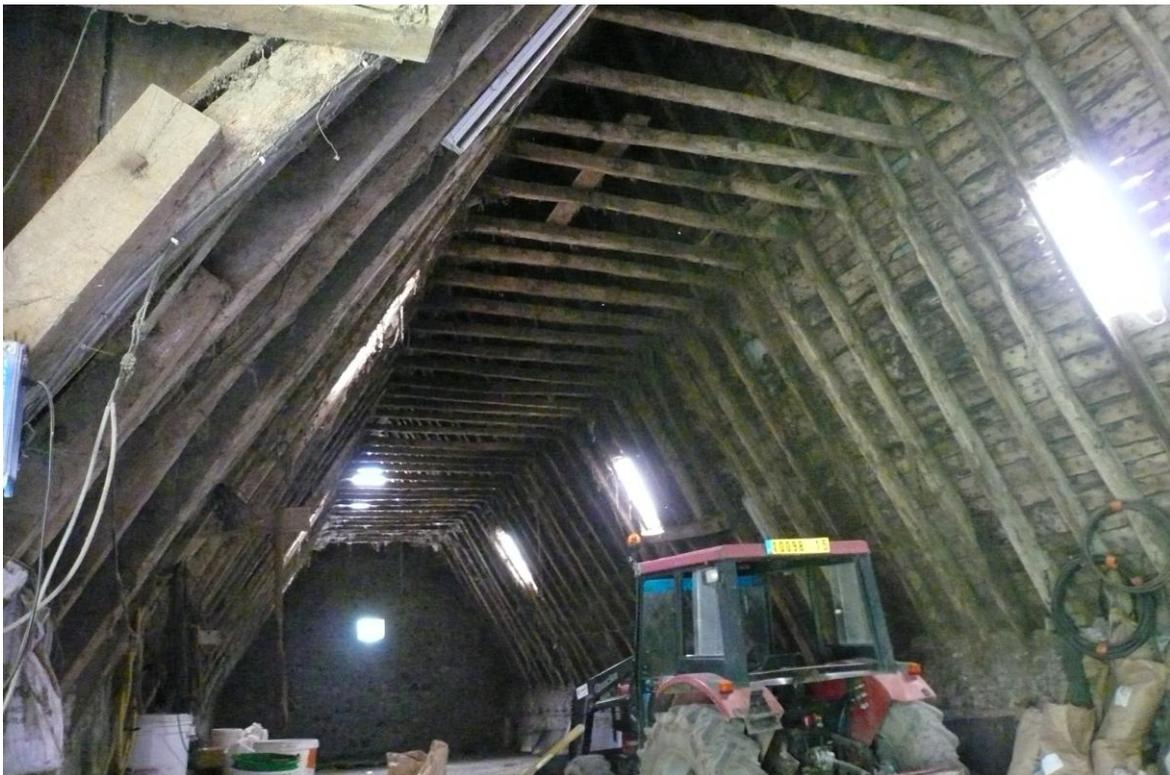
Fig. 7. - Charpente de la grange à abside.
