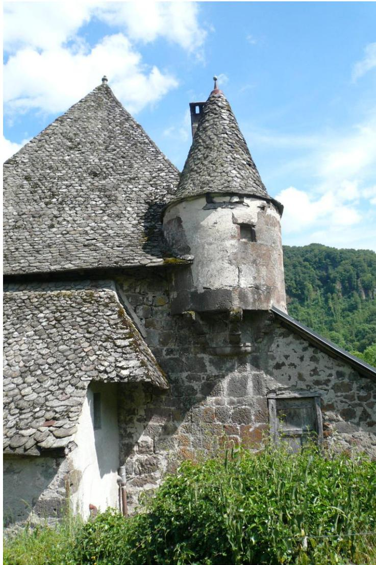
Fig. 13. - Fracor, échauguette et appentis.
