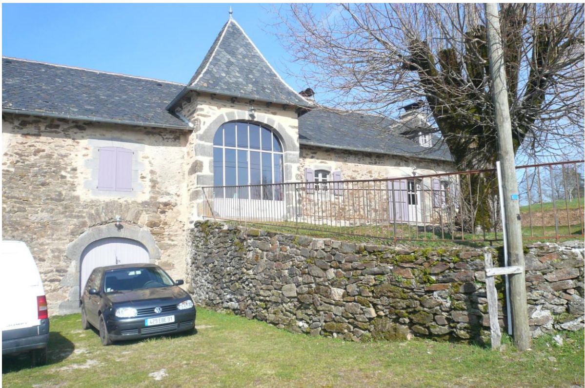
Il s'agissait là d'une ferme bloc avec création d'une verrière à la place de l'entrée de la grange et ouvertures d'une fenêtre à gauche au dessus de l'étable. Une autre fenêtre se trouve un peu plus loin.
