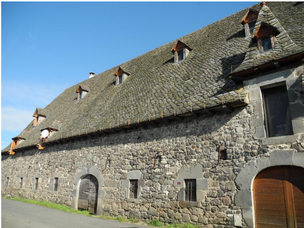
Un peu plus évoluée avec ouvertures sur 3 niveaux sur le toit dont 2 dans l'épaisseur du mur. Les ouvertures du bas semblent avoir été conservées dans leur dimensions d'origine.
