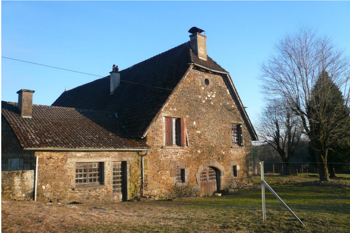
Au plus simple ; percement de 2 fenêtres au niveau grange avec probablement une entrée sur la montée, et conservation de l'étable
