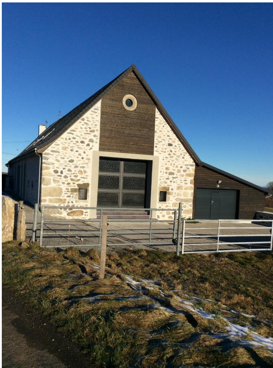
Cette rénovation se trouve à valette.
