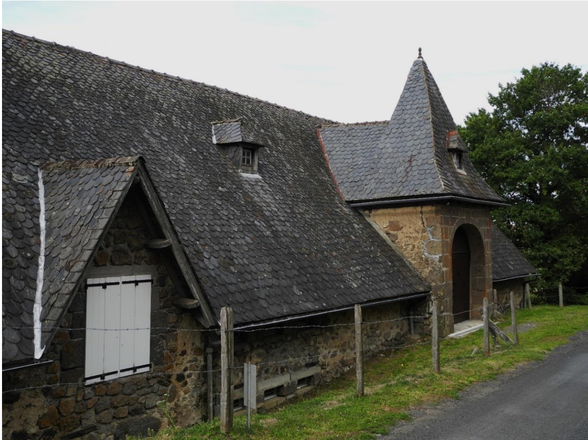
Très belle entrée avec rappel de la toiture en pointe au-dessus de la fenêtre ouverte dans le mur gouttereau.
