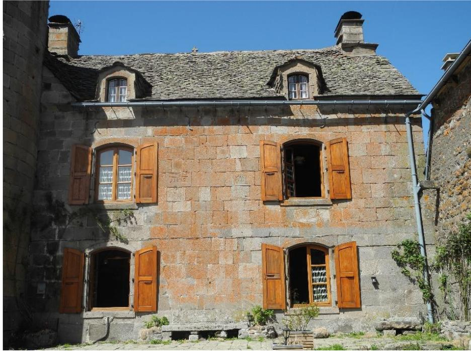
On doit donc considérer que cette partie droite du bâtiment a subi dans les années 1750, une importante rénovation, créant ces 4 ouvertures cintrées dans le style typique de l'époque. L'homogénéité apparente de la maçonnerie témoigne du soin apporté à cette transformation : il ne subsiste pas de traces des très probables ouvertures antérieures. Des documents existent peut-être qui pourraient nous renseigner sur ces travaux.
